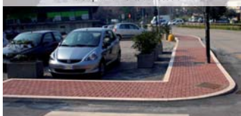
Sistemazione del parcheggio e realizzazione di nuovi marciapiedi di fronte alle scuole
